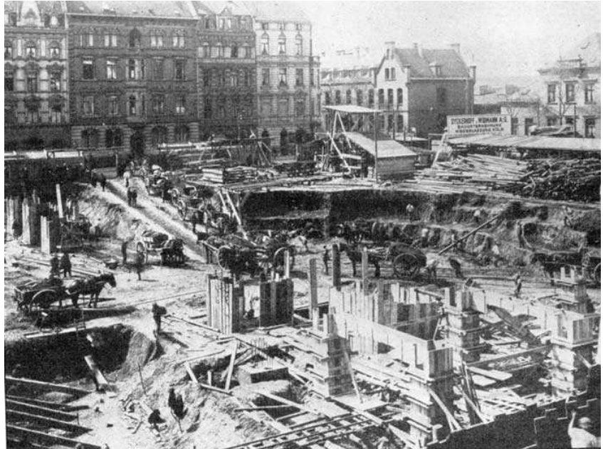
Abb.9:Die Baugrube mit Blick auf die Ritterstraße
