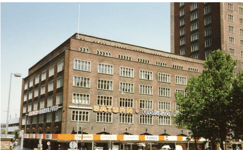
Abb.19: Ansicht mit alter unschöner Fassadenwerbung
